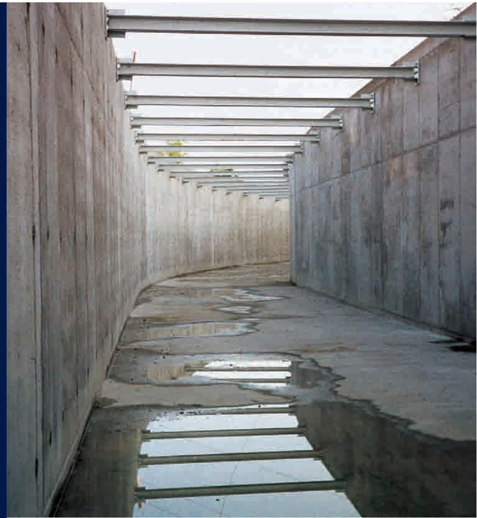
2000 – Demolizione e ricostruzione canale rettangolare di adduzione alla vasca di carico (2.500 ml). Centrale Idroelettrica di Bolognano (Pescara) - ENEL Produzione Spa
