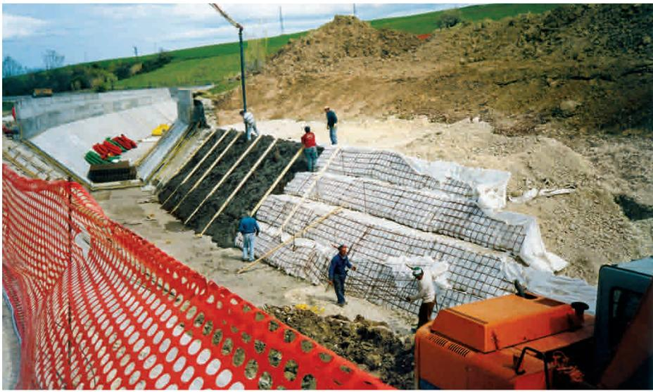
2000 – Demolizione e ricostruzione canale trapezio di adduzione e restauro dell'vasca di carico – Bolognano (Pescara) Centrale Idroelettrica - ENEL Produzione Spa
